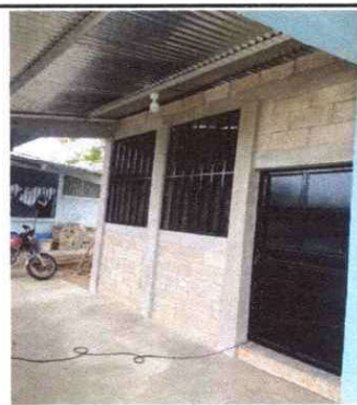
Foto 2: Sustitución de lamina en aula
