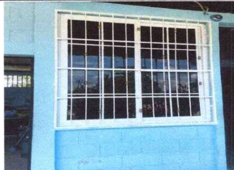
Foto 6: Sustitución de vidrios rotos por nuevos vidrios
