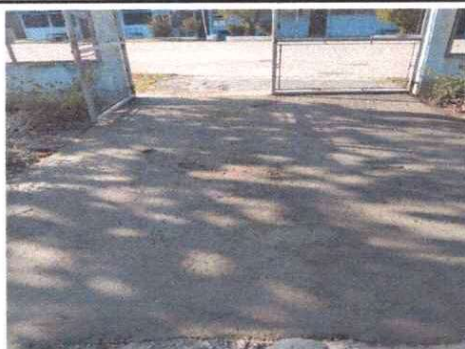
Foto 5: Reparación de entrada a la escuela
