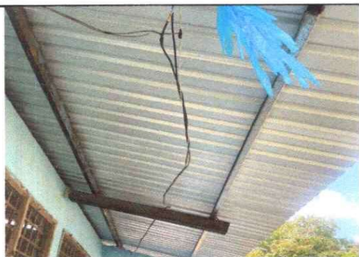
Foto 3: Instalación de cableado
