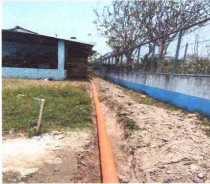
Foto 1: Instalación de tubería
