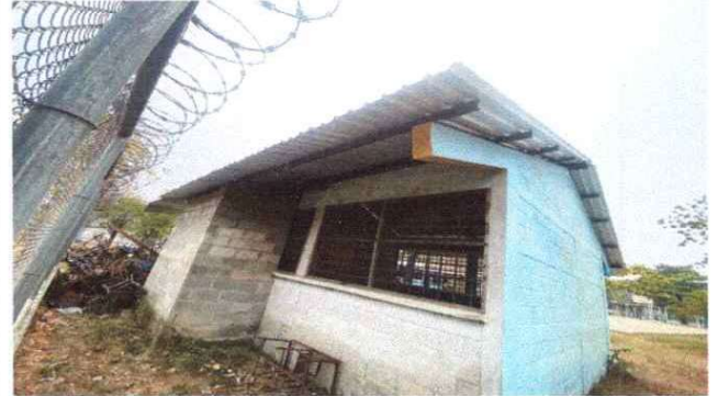
Foto 2: Sustitución de lámina
