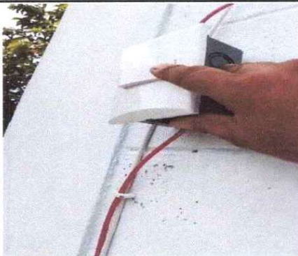
Foto 3: Instalación de cableado
