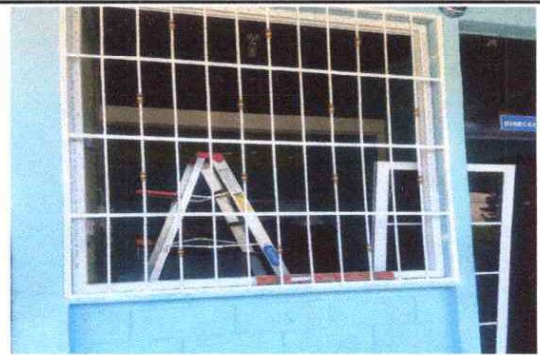
Foto 6: Sustitución de vidrios rotos por nuevos vidrios
