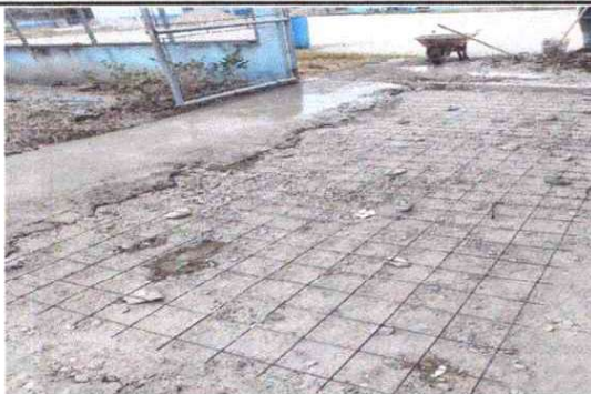
Foto 5: Reparación de entrada a la escuela
