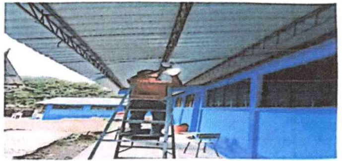
Fotografía 2 Reparación del sistema eléctrico
