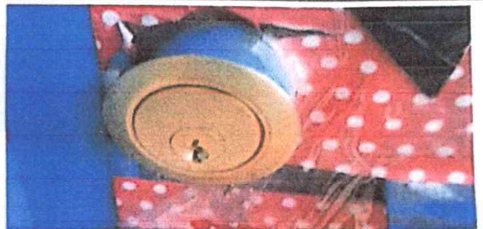
Fotografía 6 sustitución de chapa
