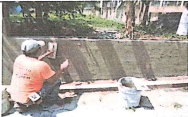
Fotografía 1 Repello del muro
