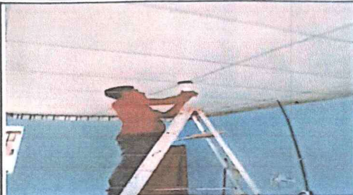
Fotografía 2 Reparación del sistema eléctrico
