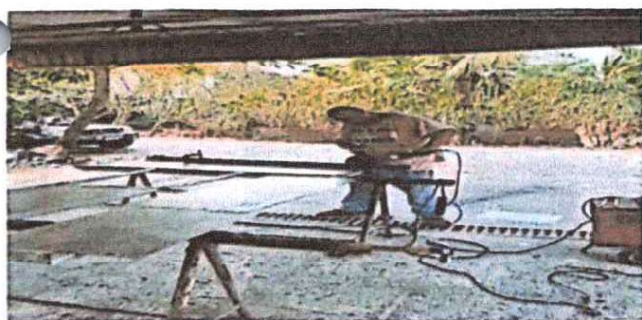
Fotografía 5 Sustitucion de portones
