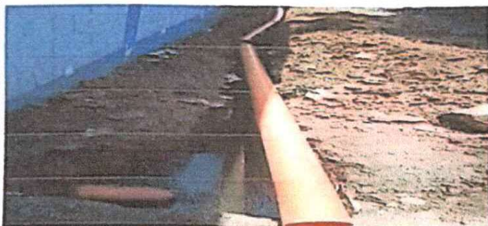
Fotografía 3 Limpieza de fosas sépticas
