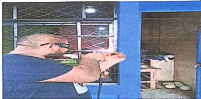
Fotografía 4 Mano de Obra Especializada
