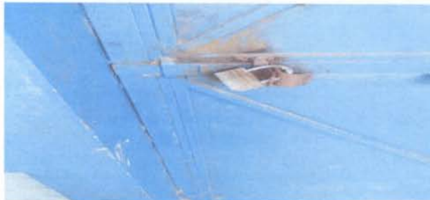
Fotografía 6 sustitucion de chapa
