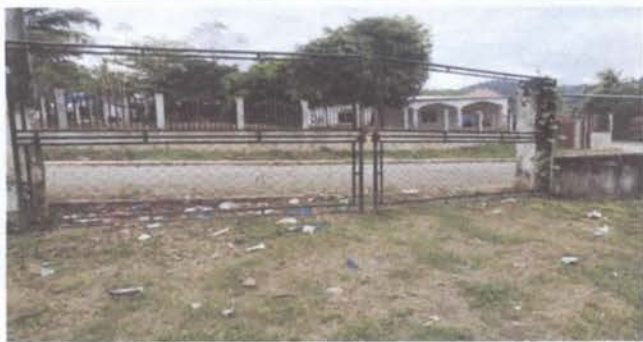
Fotografía 7 Sustitución del porton de metal
