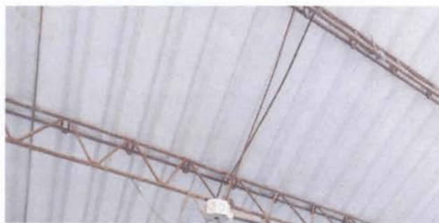
Fotografía 5 Sustitución de canal de PVC
