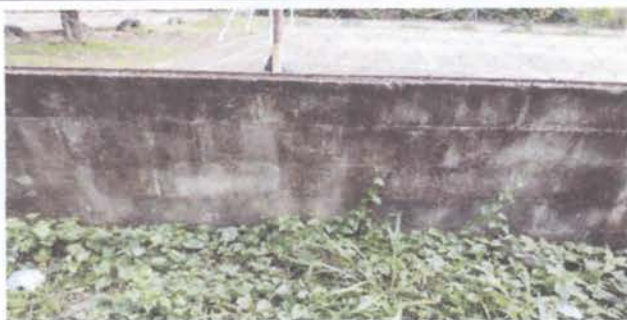
Fotografía 1 Repello del muro
