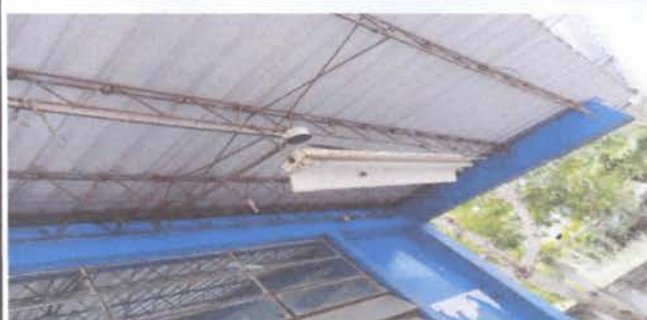
Fotografía 2 Reparación del sistema eléctrico
