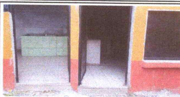
FOTO 2. COCINA Y PILA
