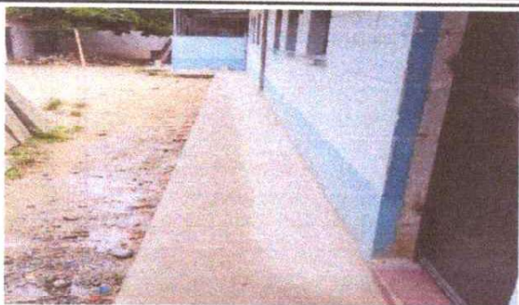
FOTO 1. ACERA DE AULAS
