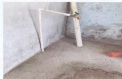
8. Mantenimiento Caja de Registro
