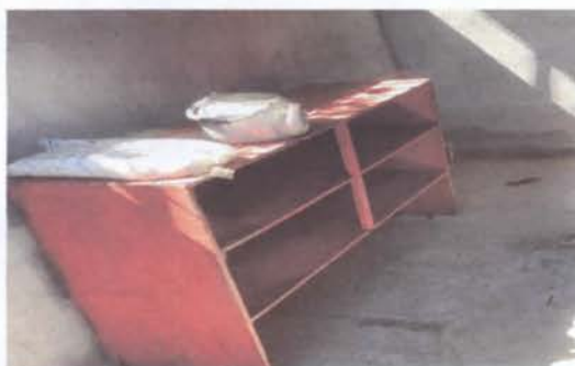
3. Sustitucion por meson de concreto, para servir alimentos
