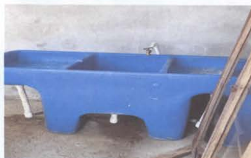
2. Sustitucion de pila por artesanal
