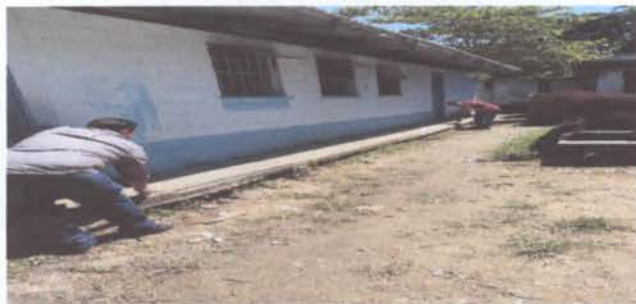
7. Mantenimiento de banqueta
