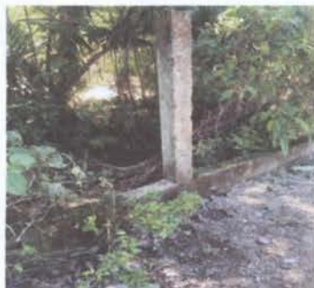
5. Manteniminto de Muro Perimetral
