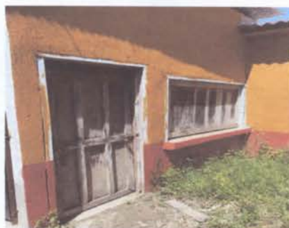
4. Sustitucion de puerta y ventana de metal
