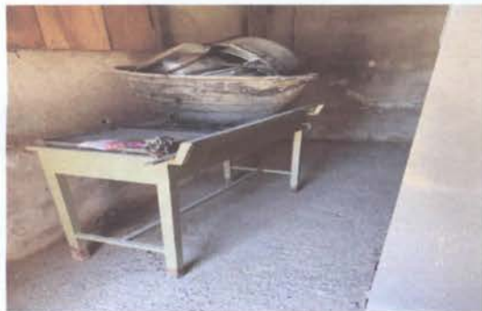
1. Sustitucion por piso de granito
