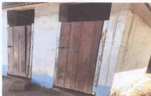
6. Matenimiento de Servicios Sanitarios
