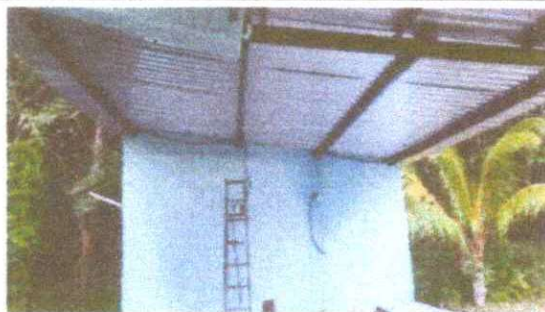
Foto 12: SUSTICIÓN DE SOPORTE DE MADERA POR METAL
