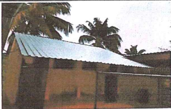
Foto 3: Sustitución de lámina
