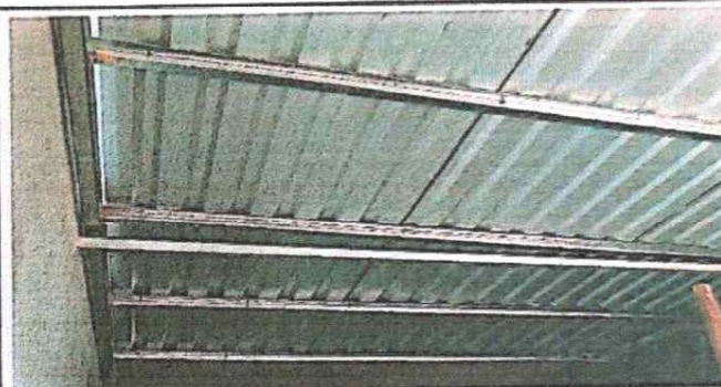
Foto 4: Sustitución de estructura soporte de metal
