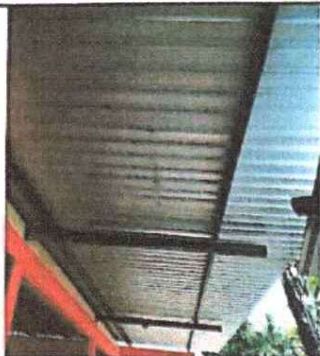
Foto 1: Sustitución de lámina
