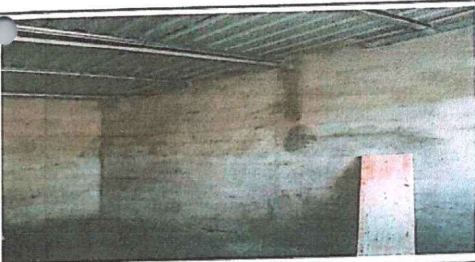
Foto 5: Sustitución de piso
