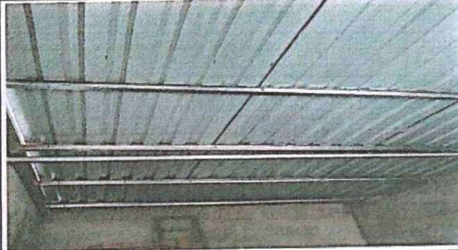
Foto 4: Sustitución de estructura soporte de metal
