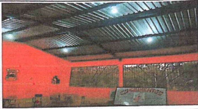
Foto 2: Sustitución de plafoneras, focos y cableado
