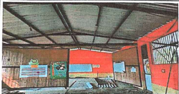
Foto 1: Sustitución de lámina
