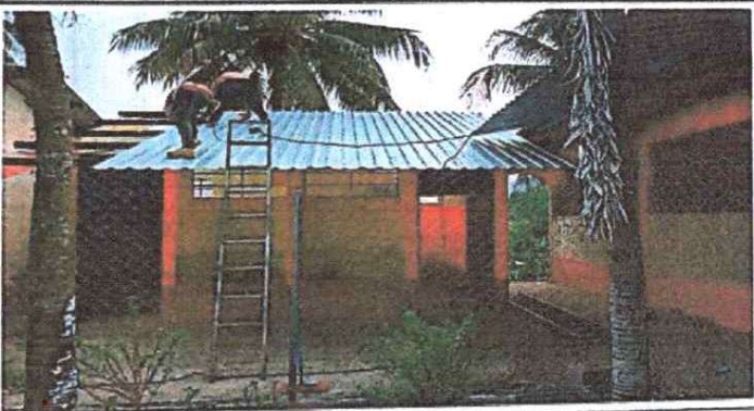
Foto 3: Sustitución de lámina
