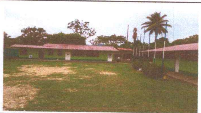
Se le dio mantenimiento al techado como soporte de metal, se elimino oxido, se atornillaron algunas laminas y se pinto a dos manos con pintura anticorrosiva.
