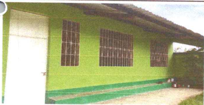
Se le dio mantenimiento a los balcones de metal, eliminando óxido y pintando a tres manos con pintura anticorrosiva.
