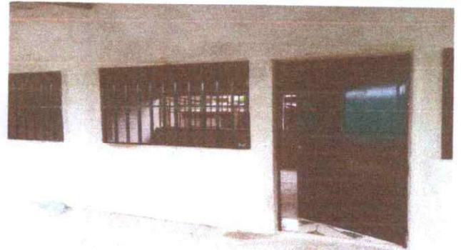
Reparación de paredes con levantado total y repellido.
