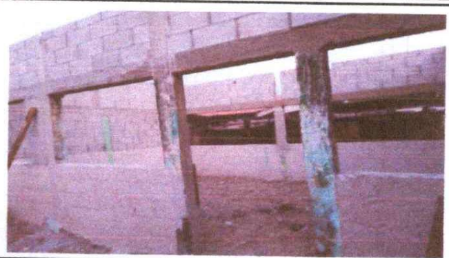
Se están reparando las paredes las que luego se repellarán en este mismo proceso. 2
