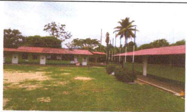
Se le está dando mantenimiento a la estructura de soporte de metal, raspando, atornillando y pintando el techo. 4
