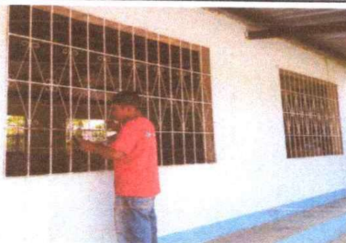
Se está quitando el óxido del balcón a través del cepillado, para luego la pintura anticorrosiva. 5
