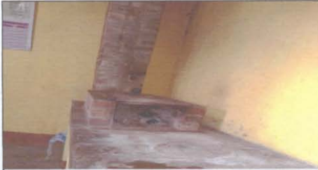
Mantenimiento de estufa rural/ se cambiaria plancha por deterioro y reparación de hornilla general.
