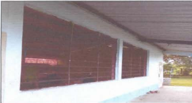
Sustitución de Estructura de Metal en Ventanas.
