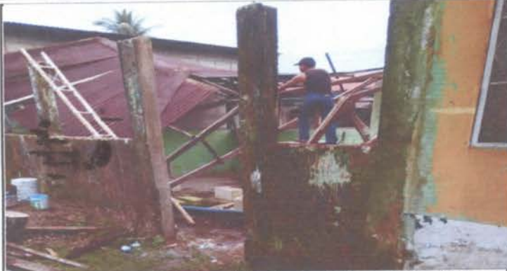
Cubierta de Lámina y Estructura de Techo, es decir se reparará estructura y techado.
