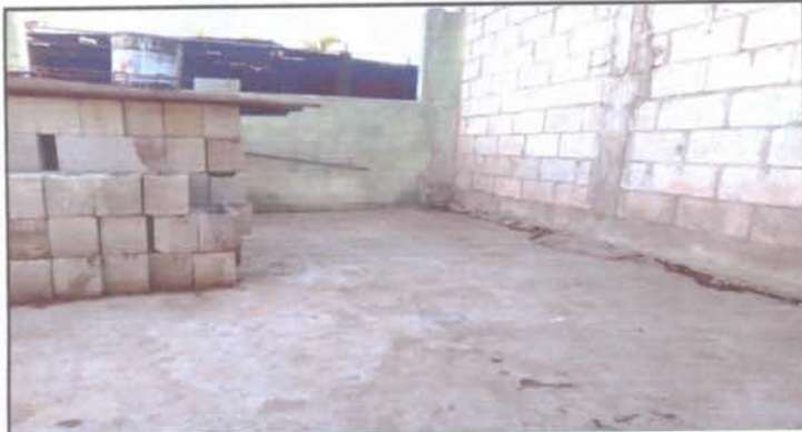
Sustitución de piso de torta de concreto.
