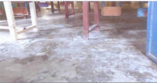
Sustitución de piso cerámico ( por deterioro de torta de cemento en centro de computación).
