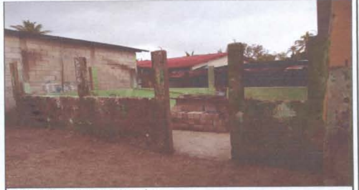
Reparación y repello de paredes
