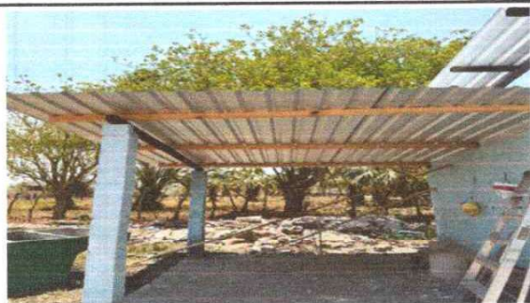
Foto 3: SUSTITUCION DE LAMINA
