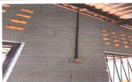
Foto 2: REPARACION DE SISTEMA ELECTRICO
