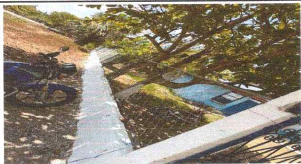
FOTO 1 SUSTITUCION DE MURO PERIMETRAL
