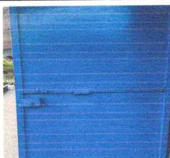
Foto 4: SUSTITUCION DE CHIAPAS Y MANTENIMIENTO A PUERTAS DE METAL
