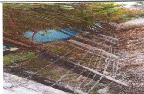
Foto 6: SUSTITUCION DE CERCO DE ALAMBRE DE PUAS
