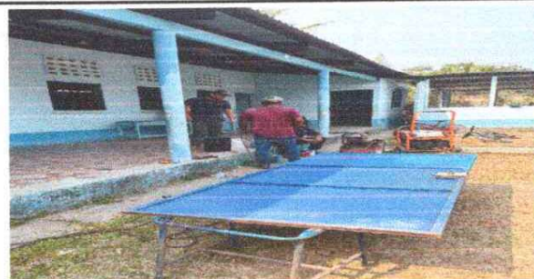
Foto 4: SUSTITUCION DE CHIAPAS Y MANTENIMIENTO A PUERTAS DE METAL
