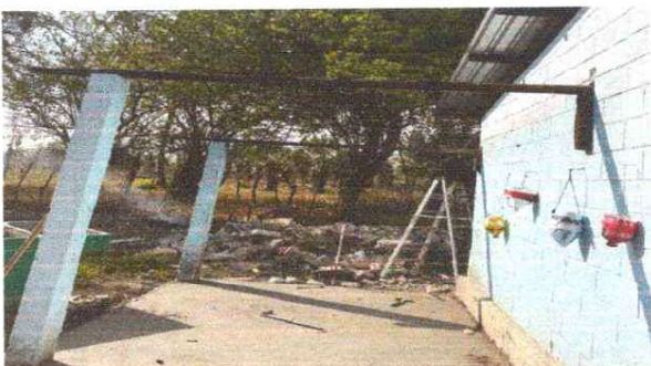
Foto 3: SUSTITUCION DE LAMINA
