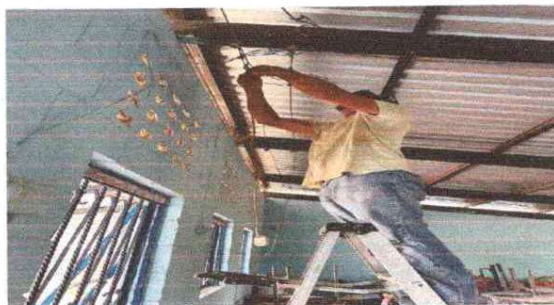
Foto 2: REPARACION DE SISTEMA ELECTRICO
