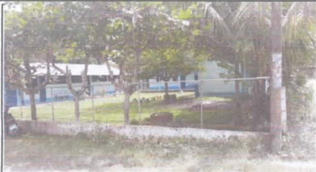
Reparacion de muro perimetral
