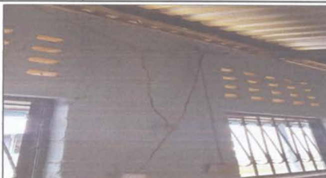
Reparacion del sistema electrico
