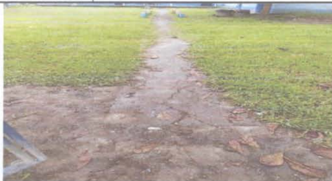
Reparacion de losa de patio
