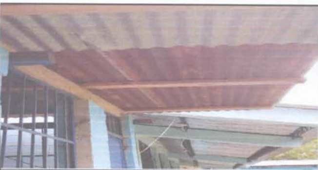
Sustitucion de lamina
