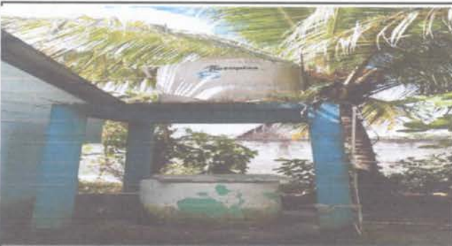
Sustitucion de accesorios de deposito de agua
