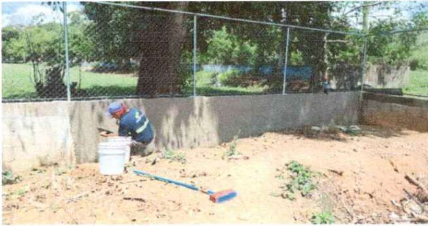
foto 1: Reparacion de muro perimetral de block con tubo y malla galvanizada, soleras intermedias y columnas.
