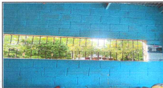
Foto 15: Fabricación e Instalación de ventana-balcon de metal
