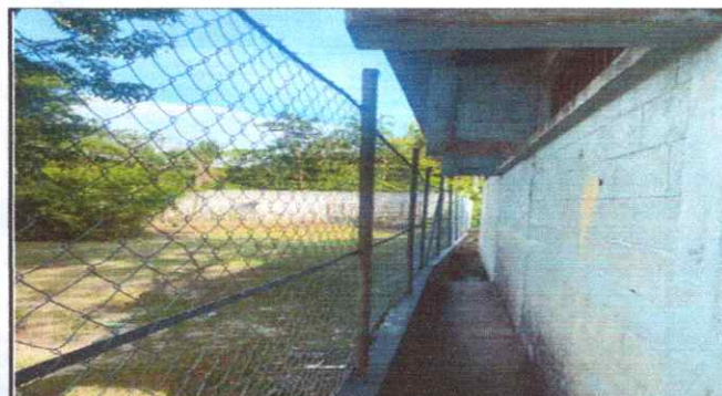
Foto 14: Reparación de muro perimetral de block con tubo GH y malla galvanizada, soleras intermedias y columnas
