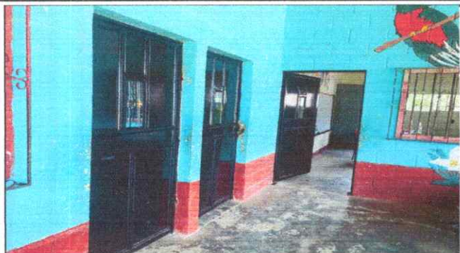
Foto 11: SUSTITUCIÓN DE PUERTAS
