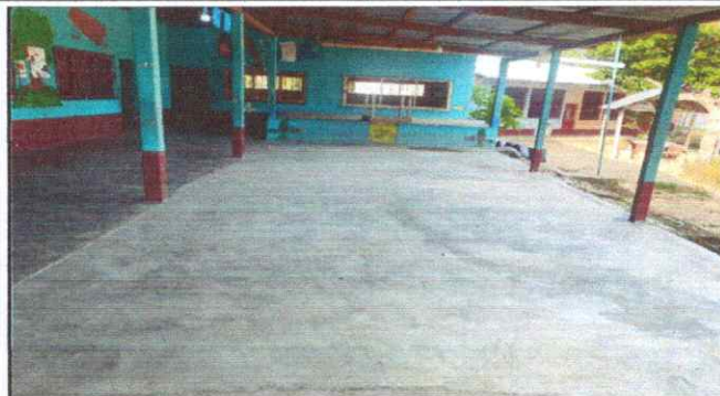
Foto 12: REPARACIÓN DE TORTA DE CEMENTO
