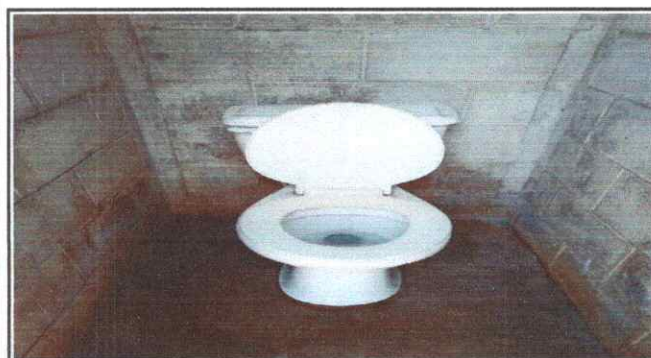
Foto 13: Sustitución de Inodoros
