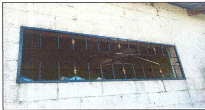
Foto 10: Fabricación e Instalación de ventana-balcon de metal
