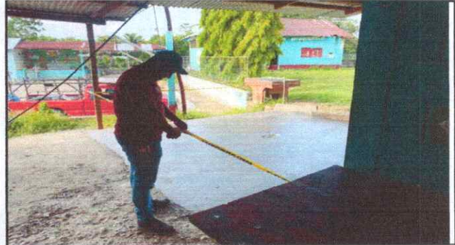
Foto 7: REPARACIÓN DE TORTA DE CEMENTO
