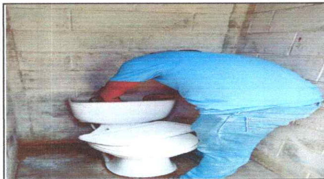
Foto 8: Sustitución de Inodoros
