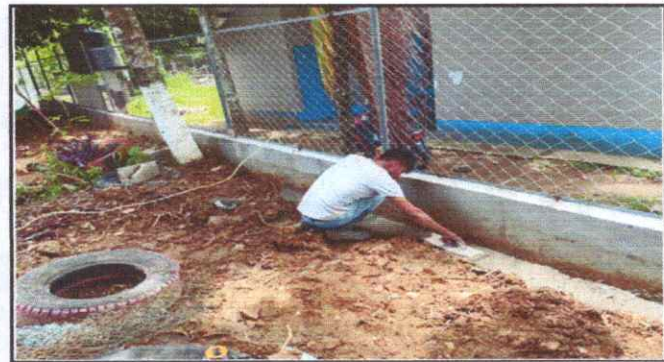
Foto 9: Reparación de muro perimetral de block con tubo GH y malla galvanizada, soleras intermedias y columnas
