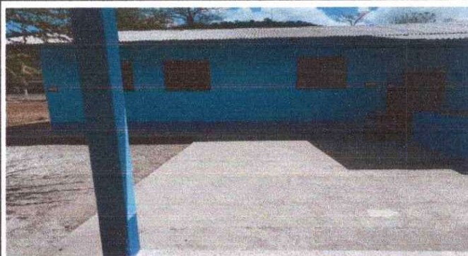
FOTO 4. Reparacion de tortas de concreto.
