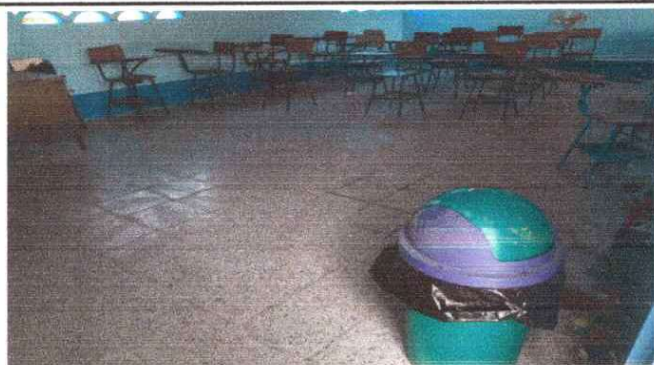
FOTO1. Sustitucion de piso de torta de concreto por piso de granito.
