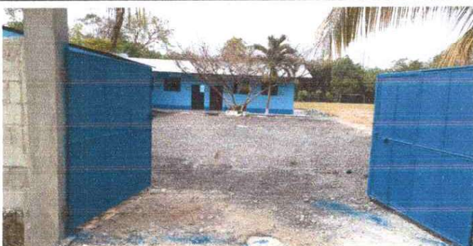
FOTO 5. Sustitucion de porton de metal.
