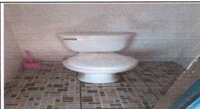
FOTO 6. Sustitucion de inodoro.
