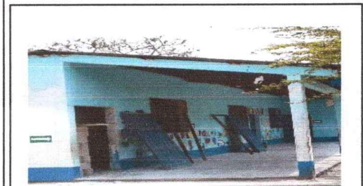
FOTO 3. Sustitucion de puerta de madera por puerta de metal
