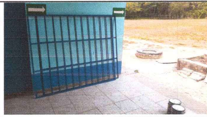
FOTO 2. Sustitucion de balcones
