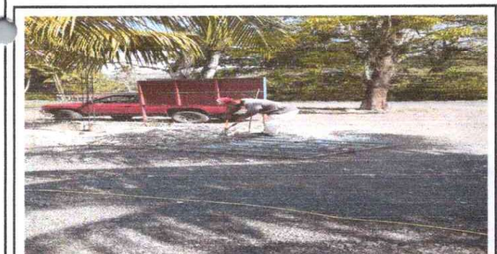
FOTO 5. Sustitucion de porton de metal.
