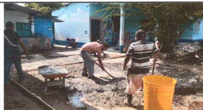
FOTO 4. Reparacion de tortas de concreto.
