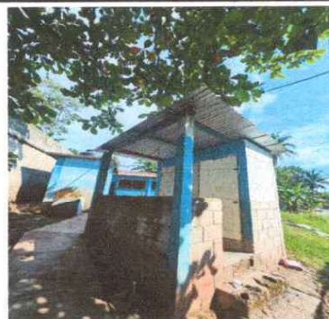
foto 2: sustitucion de estructura de techo
