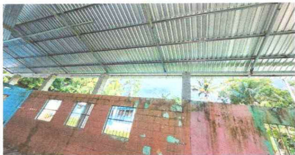
Foto 1: sustitucion de estructura de techo
