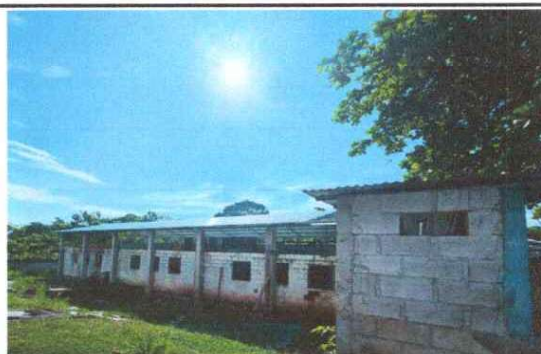
Foto 6: sustitucion bases para sosten de techo en sustitucion del muro perimetral
