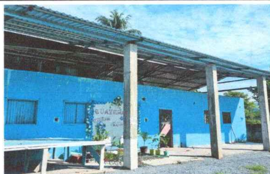
Foto 4: sustitucion de estructura de techo y reparación de luz electrica
