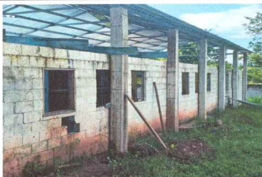
Foto 3: sustitucion de estructura de techo
