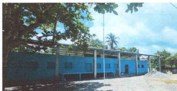
Foto 4: Sustrucción de estructura de reparacin de luz eléctrica
