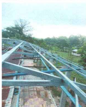
Foto 3: Sustrucción de estructura de reparacin de luz eléctrica
