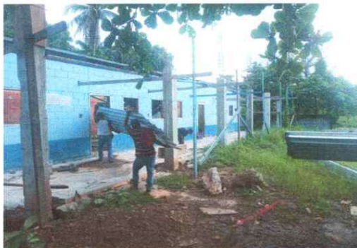
Foto 1: Sustrucción de estructura de reparacin de luz eléctrica
