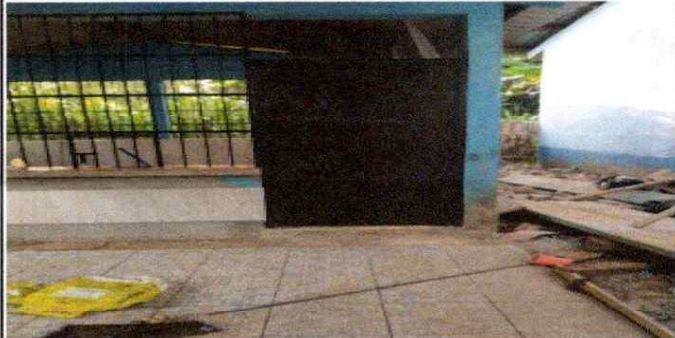
4.3 SUSTITUCIÓN DE PUERTA.
