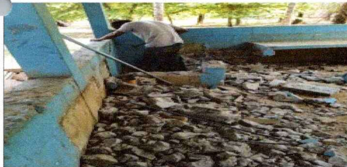
6.5 SUSTITUCIÓN DE PISO.
