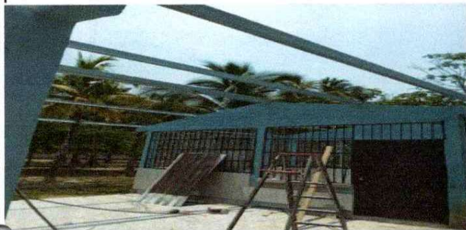
1.1 SUSTITUCIÓN DE LAMINA POR LAMINA TROQUELADA ALUZINC CALIBRE 26
