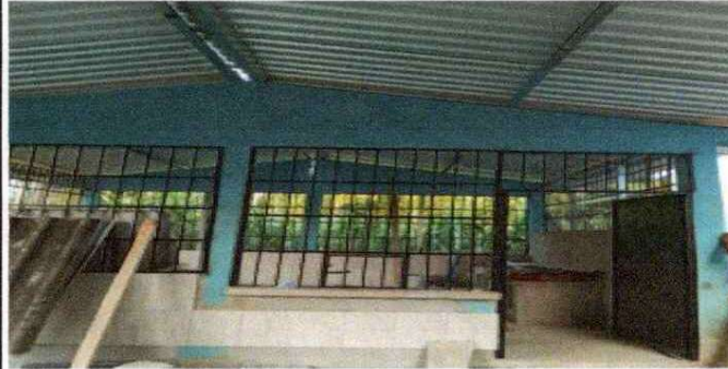
5.6 SUSTITUCIÓN DE BALCONES DE METAL.
