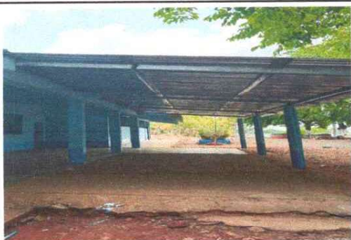
Foto 1: SUSTITUCIÓN DE LAMINA
