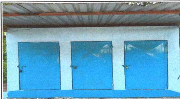
Foto 2: SUSTITUCION DE PUERTAS DE SANITARIOS
