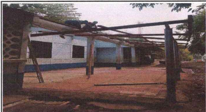
Foto1: SUSTITUCIÓN DE LAMINA
