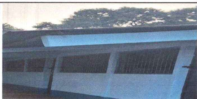
Foto 5: SUSTITUCION DE BALCONES DE ENFRENTA
