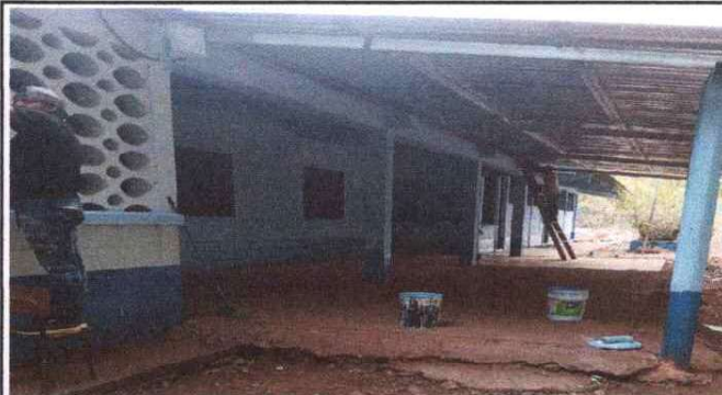
Foto 4: PINTURA EN INTERIOR COMO EXTERIOR DE PAREDES DE ESCUELA
