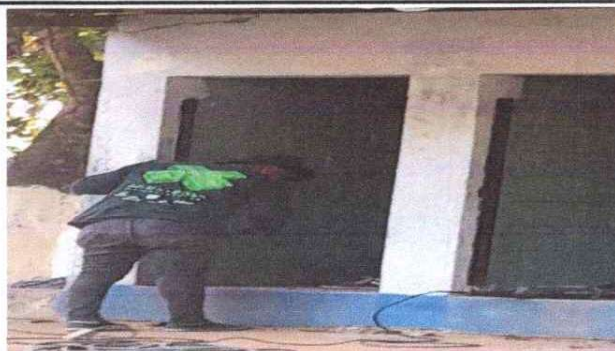
Foto 2: SUSTITUCION DE PUERTAS DE SANITARIOS
