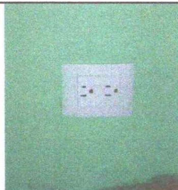
Tomacorrientes sustituidos
