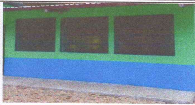
Pintura del Exterior de la Escuela Finalizada
