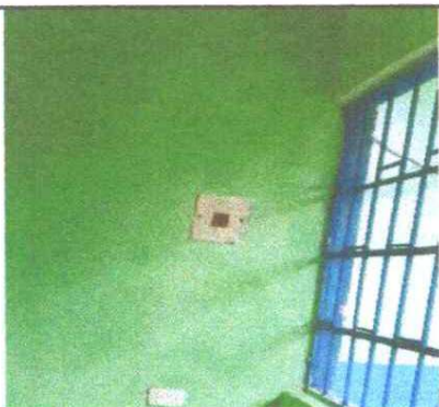
Cableado eléctrico reparado
