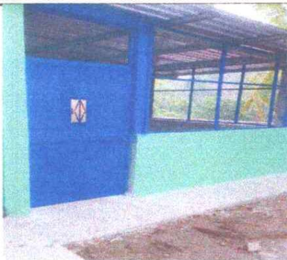
Cocina reparada y estructura del techo cambiado
