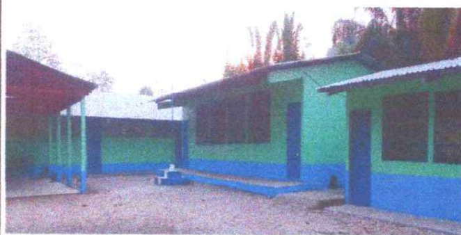
Pintura del Exterior de la Escuela Finalizada
