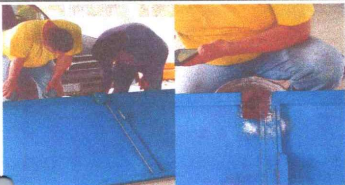
Sustituyendo chapa y arreglo de puerta
