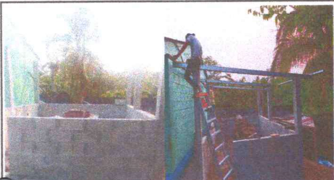
Reparando cocina, estructura del techo
