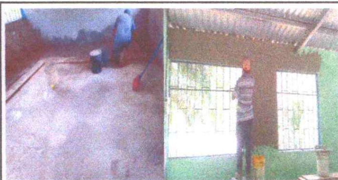
Reparando piso y repellando pared
