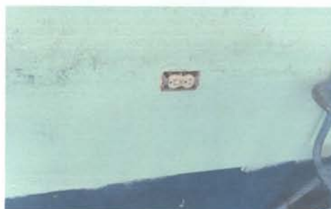
Sustitución de tomacorrientes
