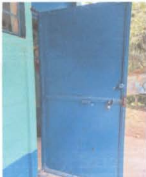
Sustitución de puerta y chapa
