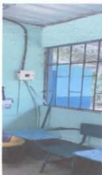
Reparación de cableado Elctrico
