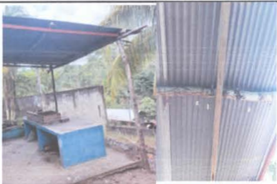
Reparacion de Cocina, estructura del techo
