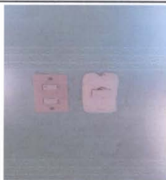
Sustitución de apagadores
