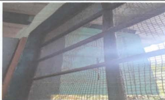
Reparacion de toda la estructura metalica
