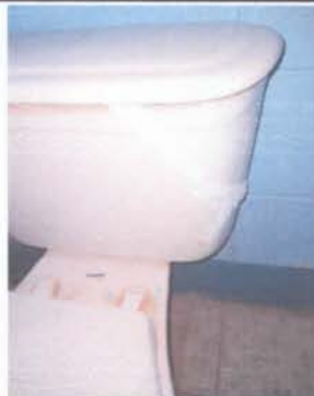
Sustitución de Sanitarios
