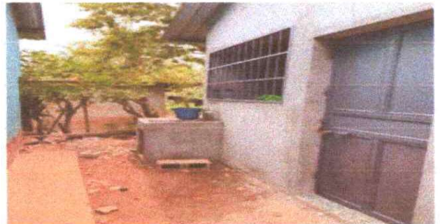
ASI QUEDA YA TERMINADA LA COCINA CON SU RESPECTIVA PILETA
