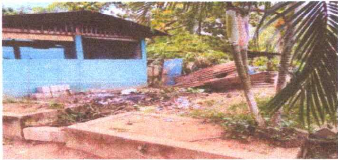
ANTES DE LA COCINA
