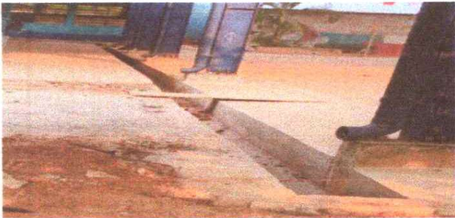
AVANCE DE LA CONSTRUCCION DE LA CUNETETA
