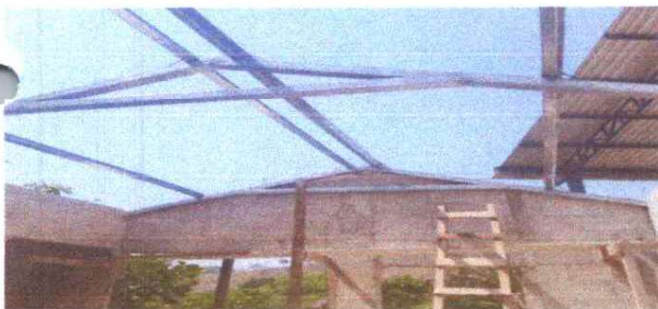
EL AVANCE LA DE LA REPARACIÓN DEL TECHO DE LA COCINA
