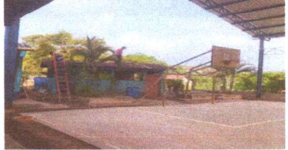
AQUI CUANDO SE EMPEZO LA CONSTRUCCIÓN
