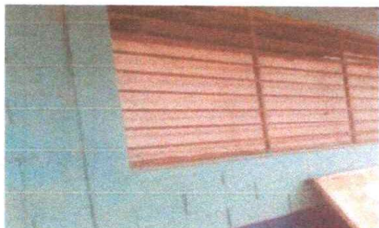
REPARACION Y PINTURA DE DOS AULAS EL ANTES
