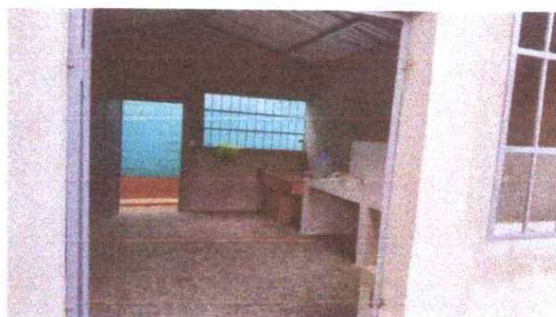
asi es como queda la cocina en su remodelacion
