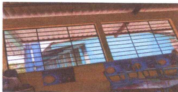
Y EL DESPUES DE LA REPARACION DE LAS TELA DE LAS AULAS
