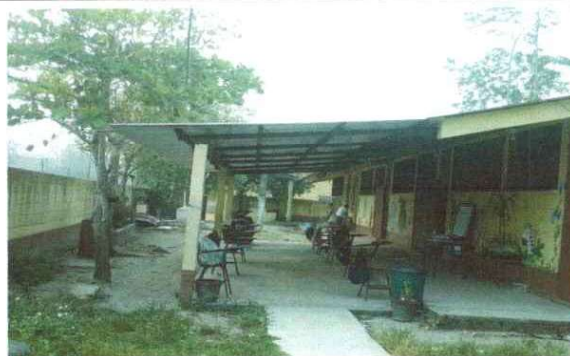
Foto 4: CAMBIO DE TECHO DE CORREDOR DE ESCUELA
