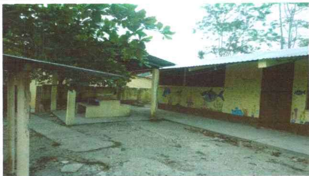
Foto 1: CAMBIO DE TECHO DE AULA
