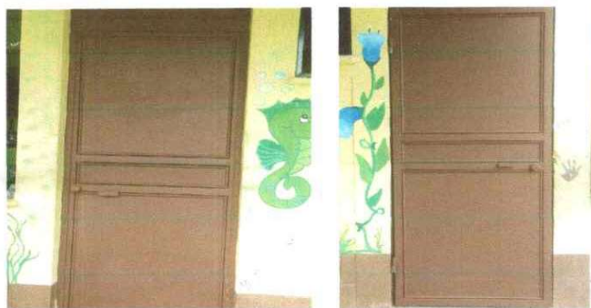
Foto 3: SUSTITUCIÓN DE PUERTAS DE METAL
