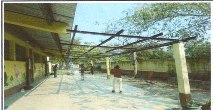
Foto 4: CAMBIO DE TECHO DE CORREDOR DE ESCUELA
