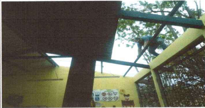
Foto1: CAMBIO DE TECHO DE AULA
