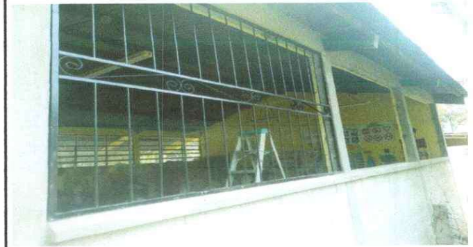
Foto 2: SUSTITUCIÓN DE BALCONES Y VENTANAS
