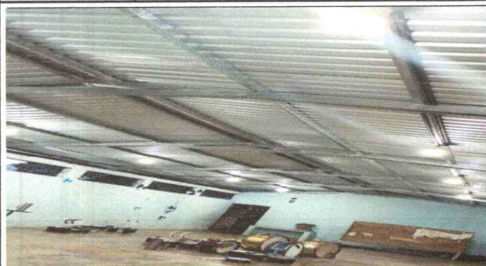
Foto 1: Desmontaje de estructura de madera mas lámina existente
