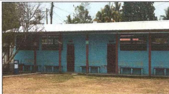
Foto 2: Desmontaje de estructura de madera mas lámina existente.
