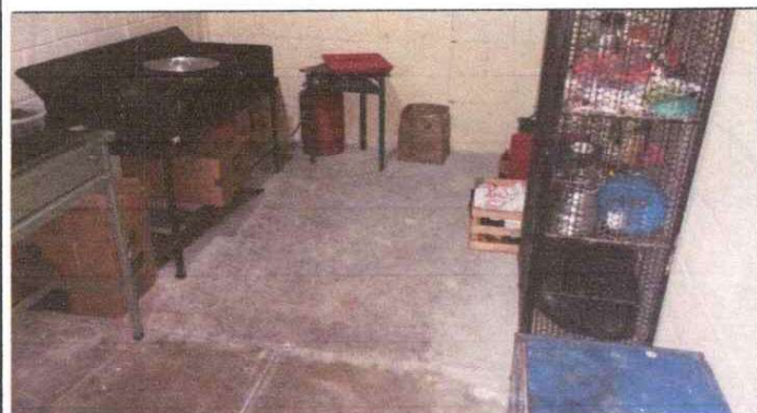
Foto 3: Fundición de piso 2.50*2.45
