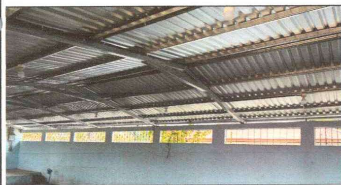
Foto 5: Instalación eléctrica global
