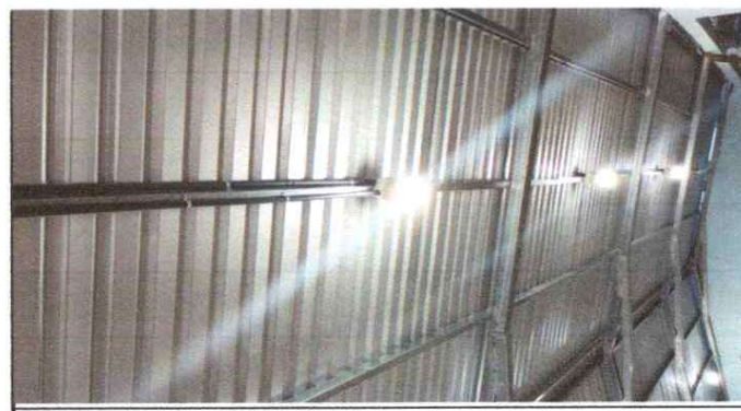
Foto 6: Instalación eléctrica global
