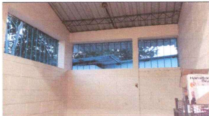
Foto 4: Construcción de Balcones
