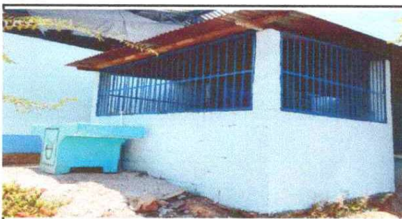
Foto 6: REPARACION DE COCINA
