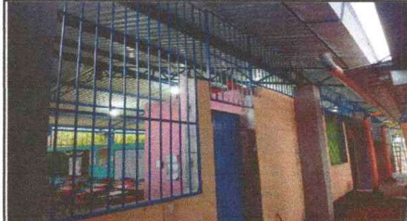
Foto 2: SUSTITUCIÓN DE BALCONES DE METAL
