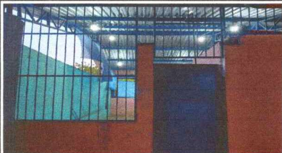
Foto 1: SUSTITUCIÓN DE PUERTA DE METAL
