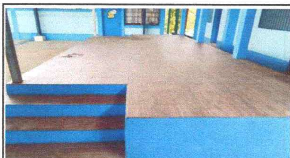
Foto 4: SUSTITUCIÓN DE PISO DE CONCRETO POR CERAMICA
