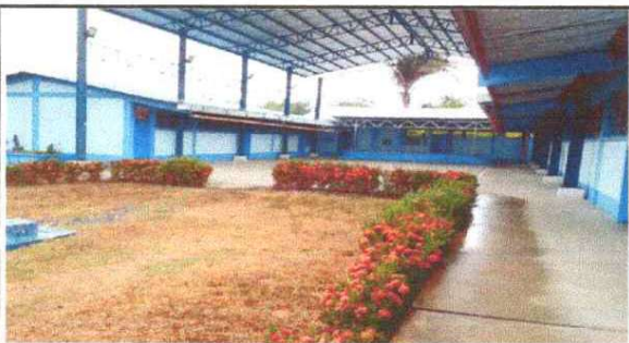
Foto 5: PINTURA EN EXTERIORES E INTERIORES
