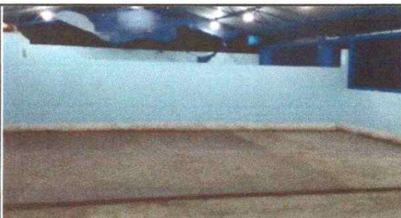
Foto 3: SUSTITUCIÓN DE PISO DE CONCRETO
