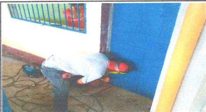
Foto1: SUSTITUCIÓN DE PUERTA DE MADERA POR METAL
