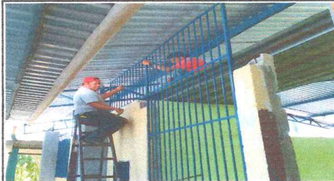
Foto 2: FABRICACIÓN DE BALCONES DE METAL
