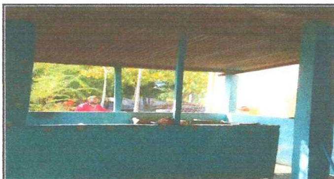
Foto 6: REPARACIÓN DE COCINA
