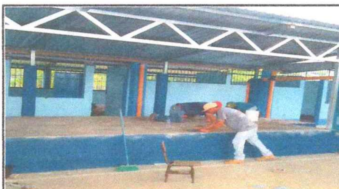
Foto 4: SUSTITUCIÓN DE PISO DE CONCRETO POR CERAMICA
