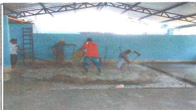
Foto 3: SUSTITUCIÓN DE PISO DE CONCRETO
