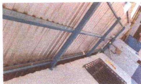
SUSTITUCION DE SISTEMA ELECTRICO
