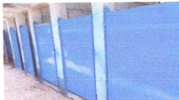
SE REALIZO LA SUSTITUCION DE PUERTAS DE SERVICIOS SANITARIOS
