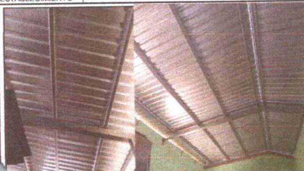
SE SUSTITUYE LA LAMINA POR LAMINA ALUCING DE CALIBRE 26
