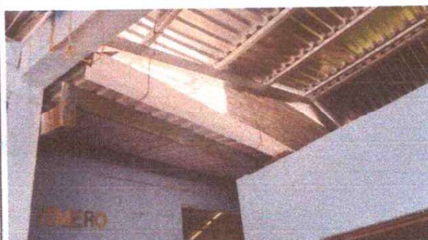
SE REALIZO LA SUSTITUCION DE CANAL PVC
