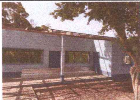
EN EL PROCESO DE CAMBIO DE LAMINA
