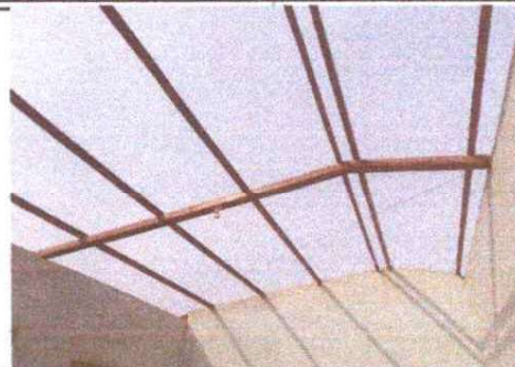
PROCESO CAMBIO DE MADERA POR ESTRUCTURA DE METAL
