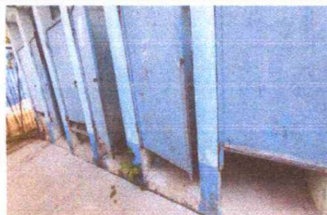
SE HARÁ CAMBIO DE LAS PUERTAS DE SERVICIOS SANITARIOS
