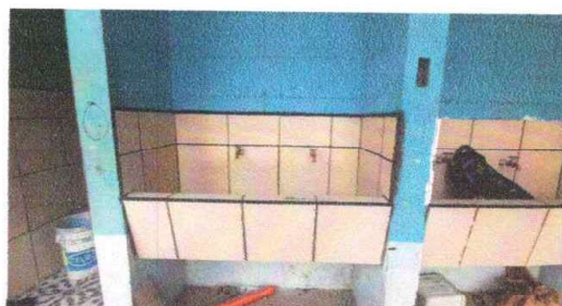
Foto 5: Instalación de azulejo en lavamanos
