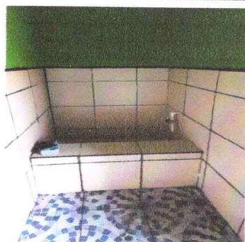
Foto 3: Instalación de azulejo en baños
