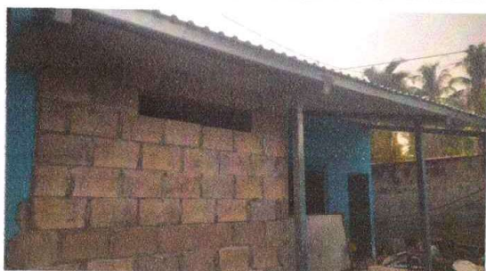
Foto1: . Muro de block.
