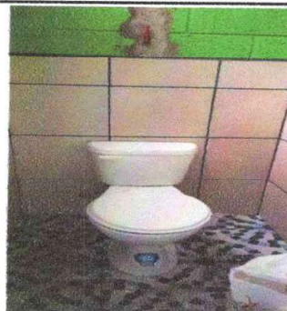
Foto 4: Instalación de servicios sanitarios
