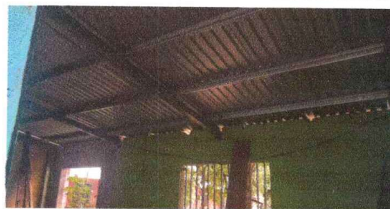
Foto 2: Techo y estructura metálica de aula.
