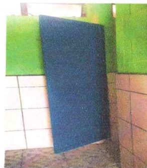
Foto 6: Instalación de puertas de servicios sanitarios
