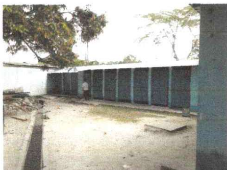
Cambio de láminas y estructura metálica en los baños.
