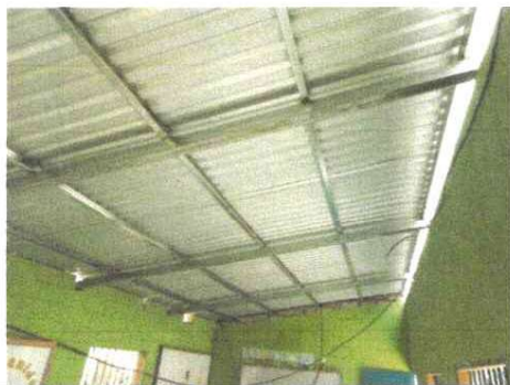
Cambio de estructura metálica en aula y corredor
