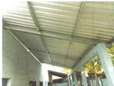
Sustitución de lámina en aula y corredor
