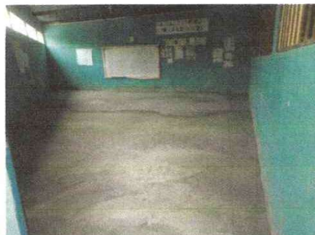
Reparación de piso de concreto en una aula
