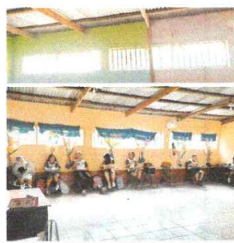
Mejoramiento de piso cerámico en 2 aulas
