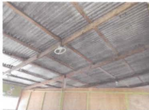
sustitución de estructura
