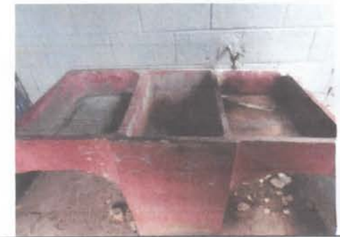
instalación de chorros
