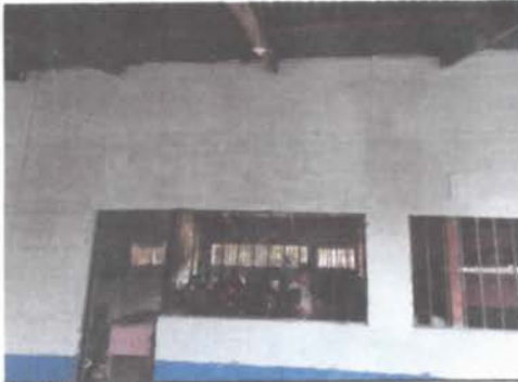
sustitución de pintura
