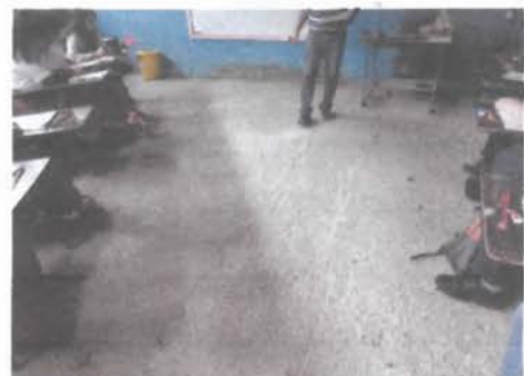
reparación de piso de concreto
