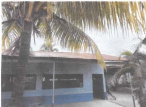
sustitución de láminas
