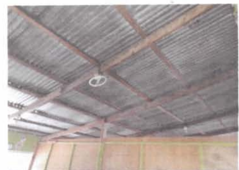
reparación de cableado eléctrico
