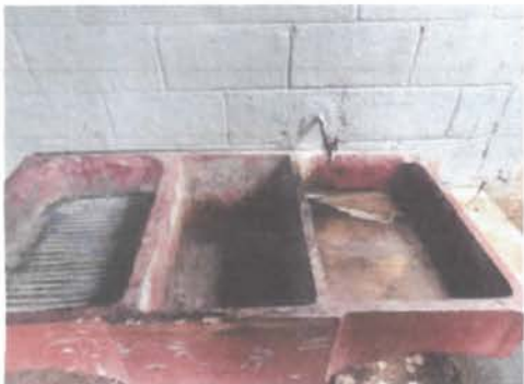
sustitución de pila
