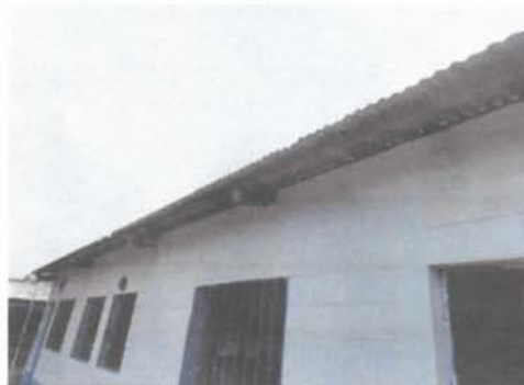
sustitución de canales
