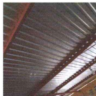
Mantenimiento de costaneras en toda la escuela
