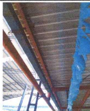
cambio de láminas en los corredores
