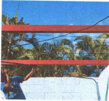
MANTENIMIENTO DE COSTANERAS Y CAMBIO DE LÁMINA DE LA ESCUELA
