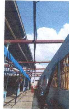
MANTENIMIENTO DE COSTANERAS Y CAMBIO DE LÁMINA DE LA ESCUELA
