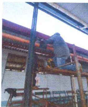
MANTENIMIENTO DE COSTANERAS Y CAMBIO DE LÁMINA DE LA ESCUELA
