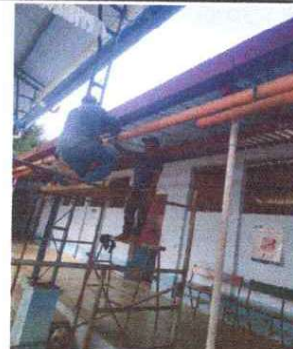
MANTENIMIENTO DE COSTANERAS Y CAMBIO DE LÁMINA DE LA ESCUELA
