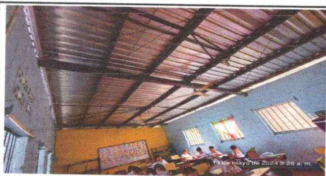
Foto 5: Sustitución de cableado eléctrico.
