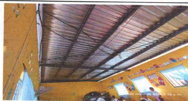
Foto 6: Sustitución de cableado eléctrico.
