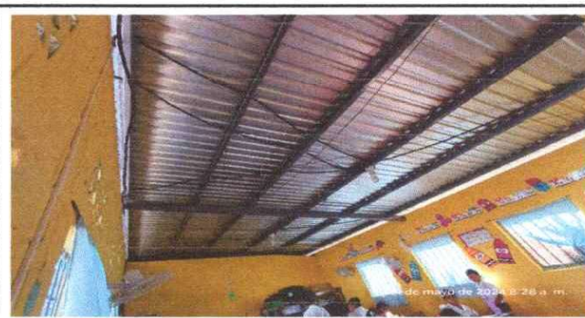
Foto 6: Sustitución de cableado eléctrico.
