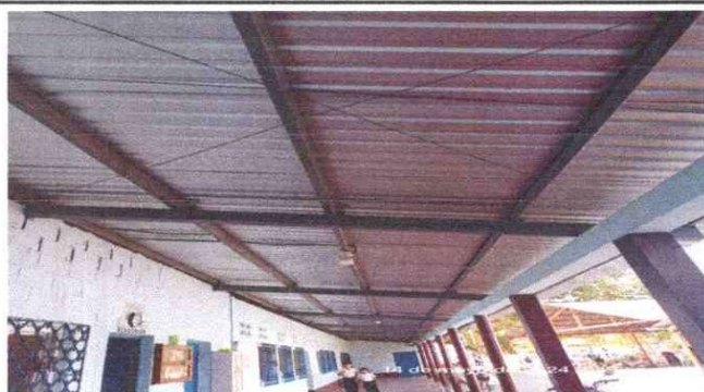
Foto 3: Mantenimiento a estructura de soporte de metal.
