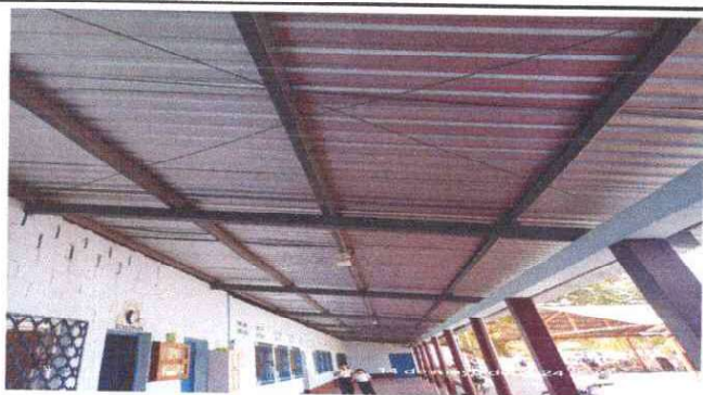
Foto 3: Mantenimiento a estructura de soporte de metal.
