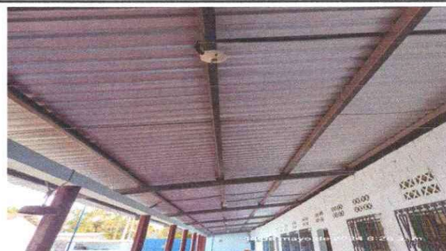
Foto 4: Mantenimiento a estructura de soporte de metal.
