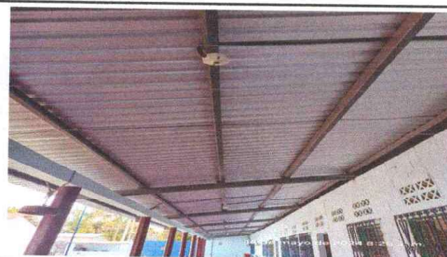
Foto 4: Mantenimiento a estructura de soporte de metal.
