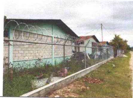
LA MALLA YA ESTA SUTITUIDA, PUESTO EL RAZOR Y EXTENSION DE TUBO
