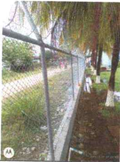
LA MALLA YA ESTA SUTITUIDA, PUESTO EL RAZOR Y EXTENSION DE TUBO
