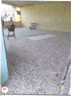
LOS PISOS DE GRANITO YA INSTALADOS
