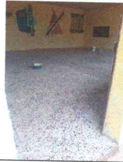
LOS PISOS DE GRANITO YA INSTALADOS
