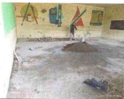
REPARACION DE LA FILTRACION
