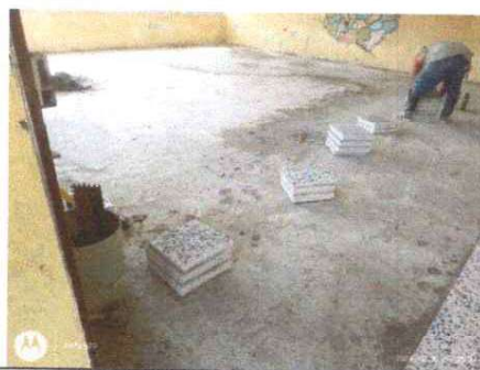
ANIVELACION Y SUSTITUCION DE PISO RUSTICO POR PISO GRANITO
