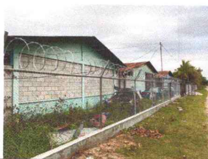
ACA YA ESTA INSTALADA PARTE DE MALLA Y EL RAZOR
