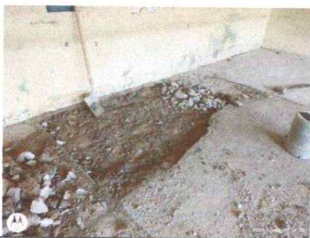
REPARACION DE LA FILTRACION
