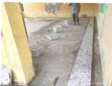
DURANTE LA INSTALACION DE PISO DE GRANITO
