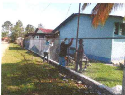
ACA SE ESTA INSTALANDO LA MALLA NUEVA
