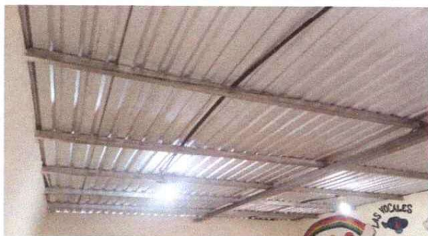
Foto1: Sustitución de lamina por lamina Aluzinc Calibre 26
