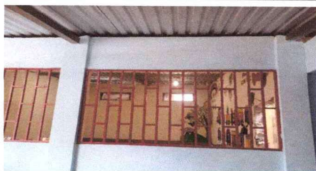
Foto 2: Sustitución de balcon de metal
