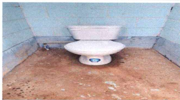
Foto 4: Sustitucion de Inodoro
