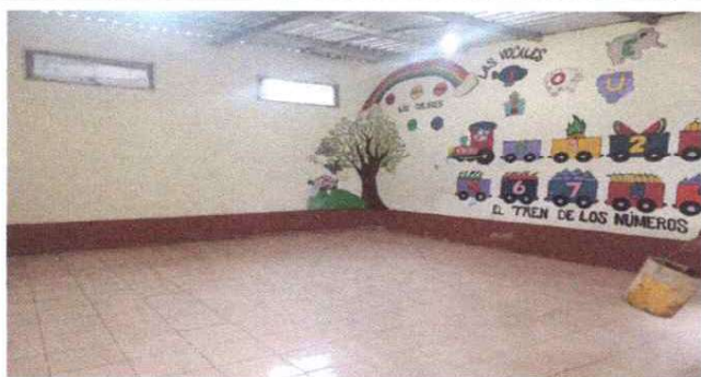
Foto 3: Mantenimiento de Piso, por piso de azulejo nuevo
