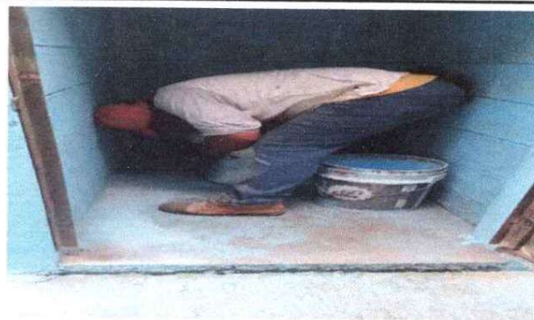
Foto 2: Mantenimiento de baño
