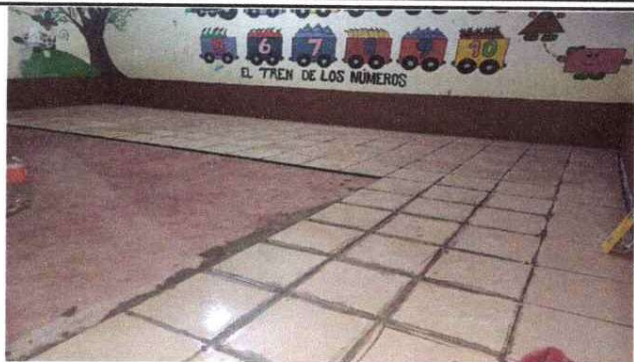
Foto 1: Mantenimiento de Piso, por ceramico nuevo
