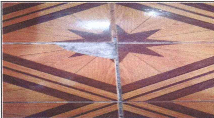
Foto 3: Sustitución de Piso de concreto por Ceramico
