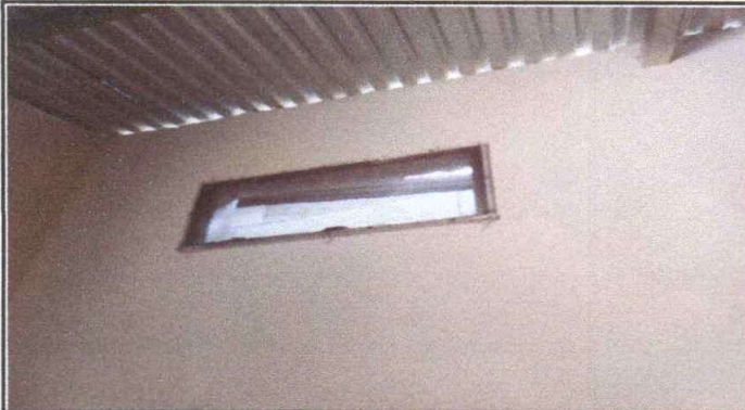
Foto 1: Sustitución de lamina por lamina Aluzinc Calibre 26
