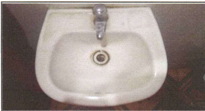
Foto 5: SUSTITUCIÓN DE LAVAMANO
