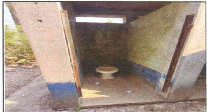
Foto 4: Sustitucion de Inodoro
