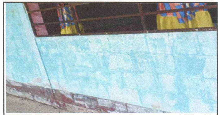
Foto 6: Pintura en muros exteriores e interiores
