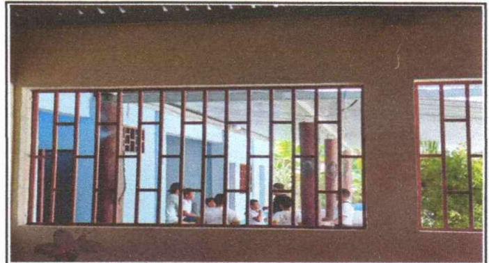
Foto 2: Sustitución de balcon de metal
