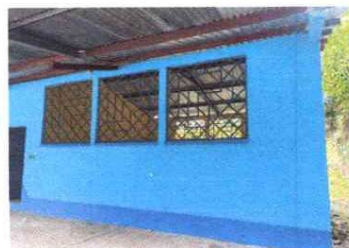
Foto 4: Pintura en muros interiores y exteriores
