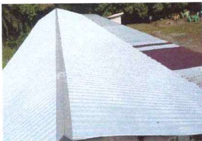
Foto1: Sustitucion de lamina
