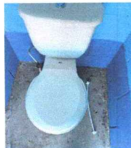
Foto 2: Sustitucion de inodoros
