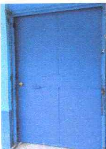
Foto 3: Sustitucion de puerta
