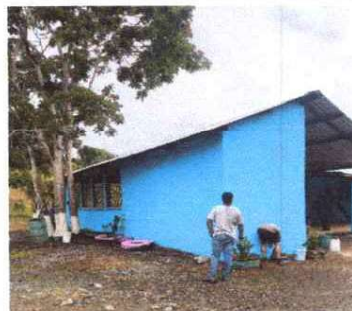
Foto 4: Pintura en muros interiores y exteriores
