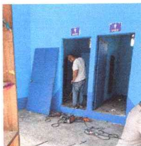
Foto 3: Sustitucion de puerta
