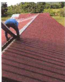
Foto1: Sustitucion de lamina
