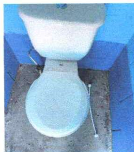
Foto 2: Sustitucion de inodoros
